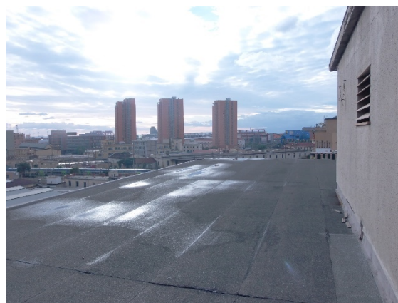
Figura 8.1 - Particolare copertura su cui intervenire.
